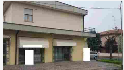
Via Damiano Chiesa n.2 - Fraz. Rovereto - 30000
